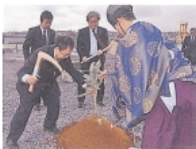
新フェリーターミナルの建設予定地でくわ入れの儀式に臨む関係者＝5日、大間町の大間港
